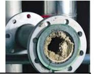
\*) Damen-Feinstrumpfhosen können bis zu 15 Meter lang werden, wenn sie sich im Schneckenpumpwerk verfangen. Sie können Rohre verstopfen, Messergebnisse verändern und sogar Pumpen und Motoren beschädigen
